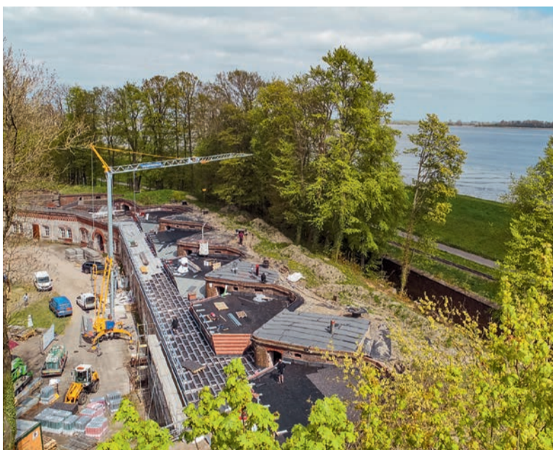
Die alte marode Dachpappe musste runter. Die Dachdecker der Gehrman Baugesellschaft verwendeten für das 600 m 2 große Dach der Festung Abdichtungsbahnen vom COBA-Vertragslieferanten Hasse & Sohn.
